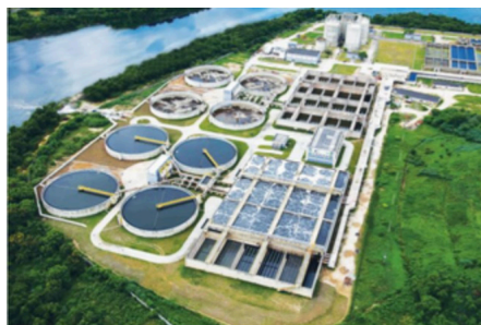
Figura 1: Exemplo de Estação de Tratamento de Esgotos (ETE).
