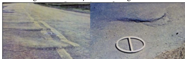
Figura 4: Ondulações e escorregamento
