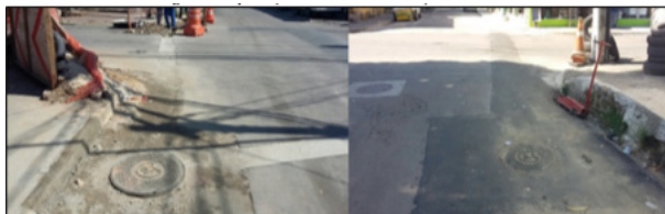
Figura 9: Implantação de rede telecomunicação subterrânea
