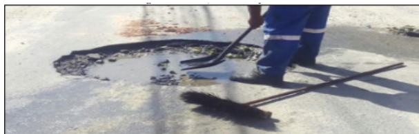
Figura 7: Buracos, cavidade ou painelas
