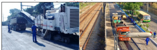
Figura 10: Fresagem e pavimentação
