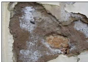
Figura 1: Patologias – Eflorescência.
