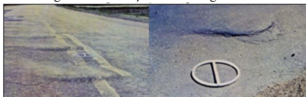
Figura 4: Ondulações e escorregamento
