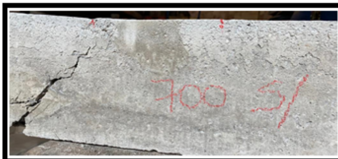
Figura 38 - Caracterização da fissuração do prisma P4
