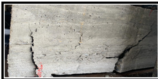
Figura 37 - Caracterização da fissuração do prisma P3
