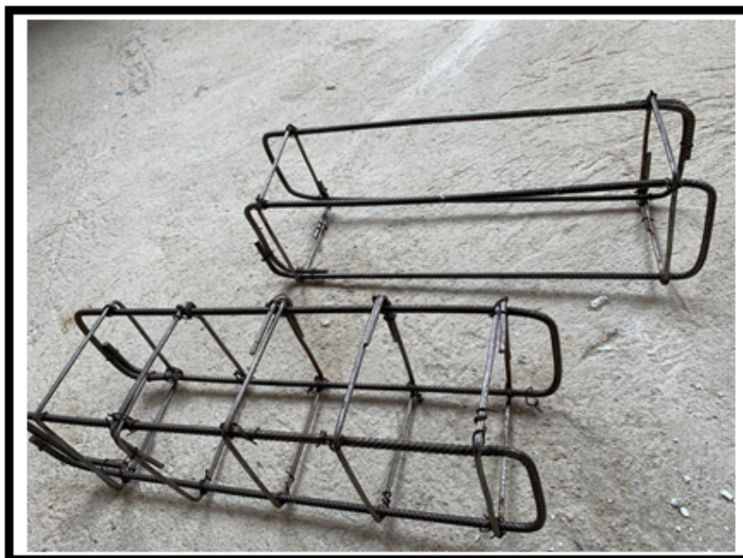
Figura 7 - Armadura transversal e longitudinal
