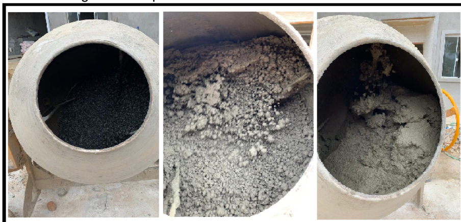
Figura 8 - Etapa de Mistura dos materiais na betoneira
