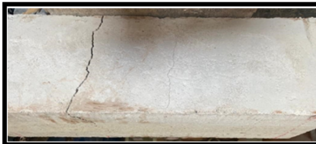
Figura 36 - Caracterização da fissuração do prisma P2
