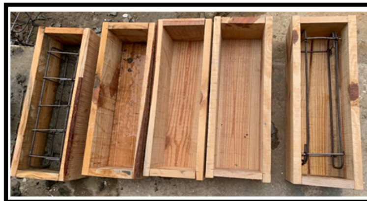
Figura 6 - Fôrma de madeira Pinus
