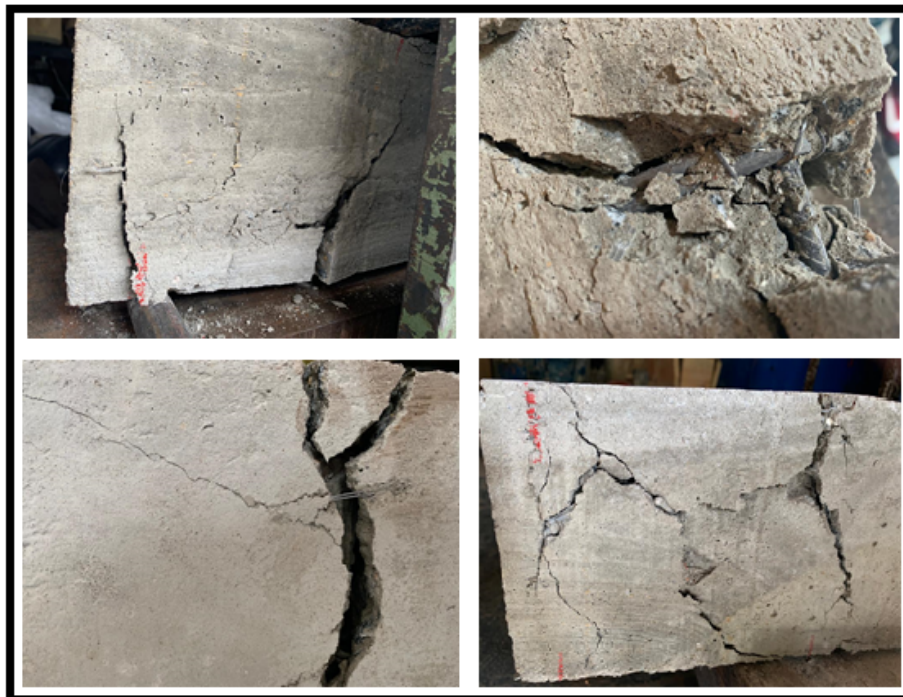
Figura 30 - Múltiplas fissuras (P3)
