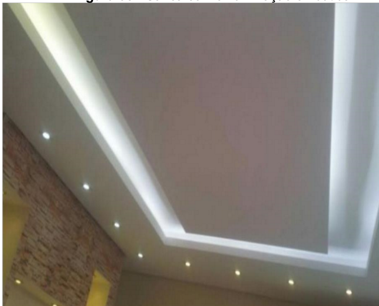
Figura 05 - Sanca com a iluminação embutida
