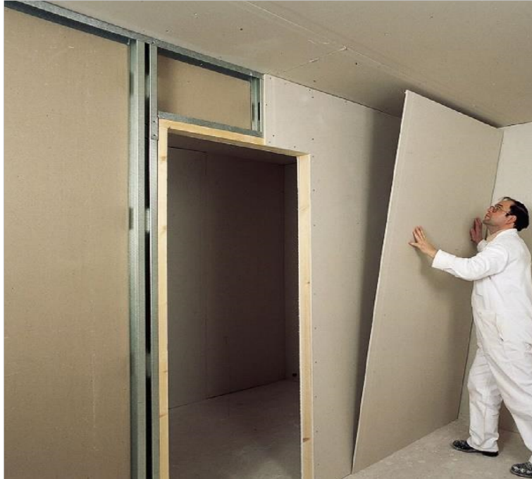
Figura 09 - Fechamento do ambiente com as placas acartonado
