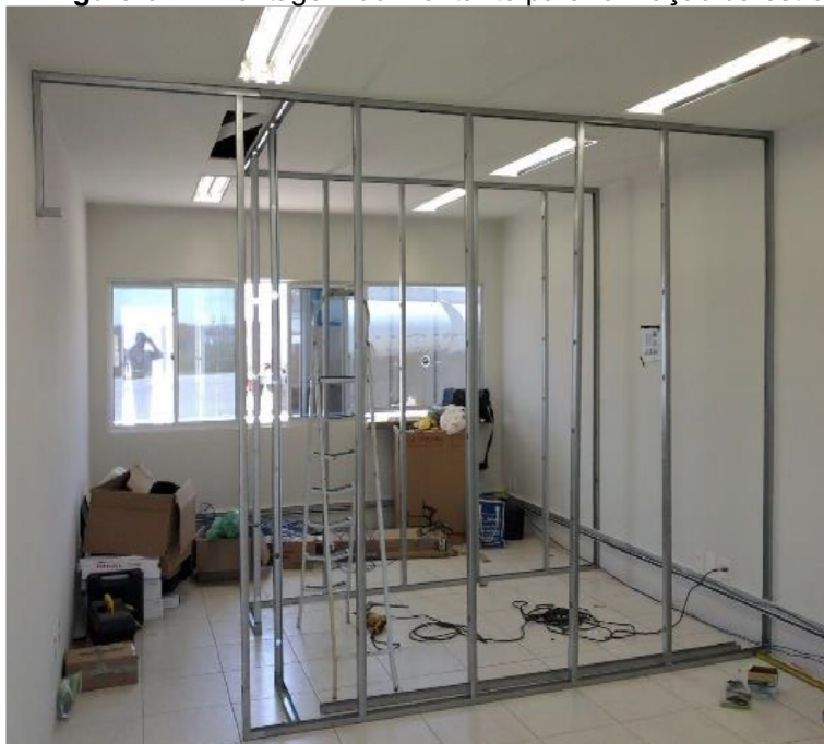
Figura 07 - Montagem do montante para formação da estrutura
