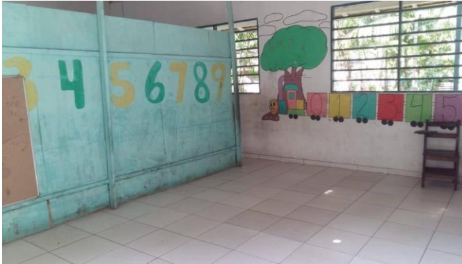
Sala, sem forro, dividida por compensado onde funcionam duas séries (Foto: Cilene Maués)
