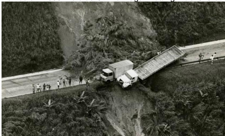
Foto 5: Trecho da estrada Rio-Petrópolis fechado por desabamento que quase levou dois veículos. Foto Luis Pinto/Agência O Globo.
