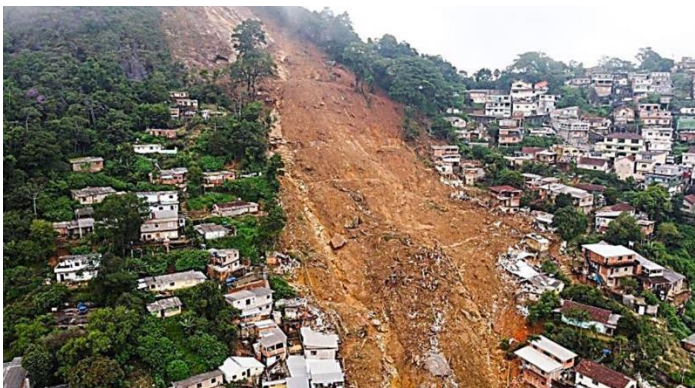
Foto 7: Deslizamento no Morro da Oficina no Alto da Serra em Petrópolis, (CNN Brasil, 16 fev. de 2022).
