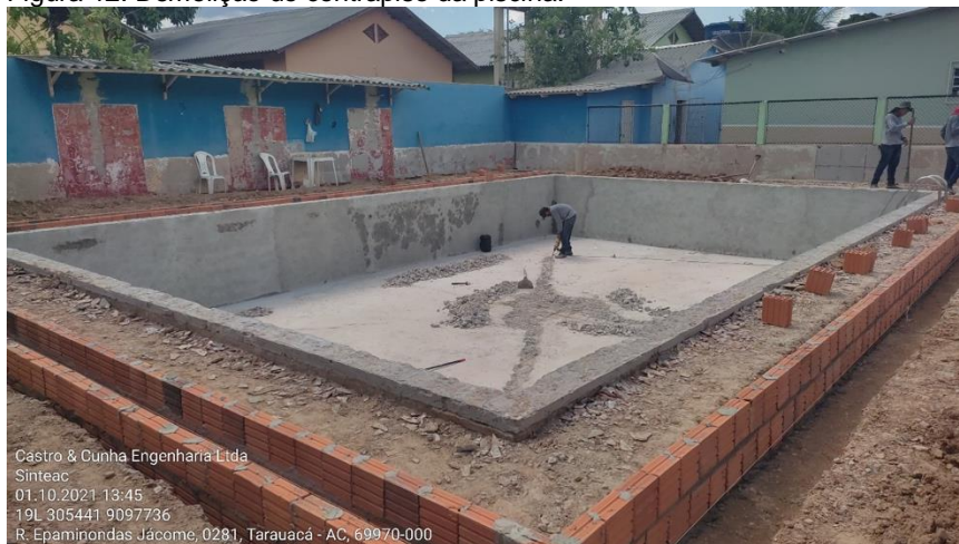
Figura 12: Demolição do contrapiso da piscina.
