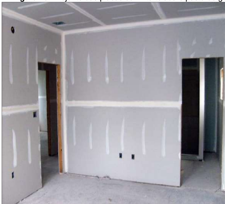
Figura 10 - Rejunte das placas com fita telada e pasta de gesso
