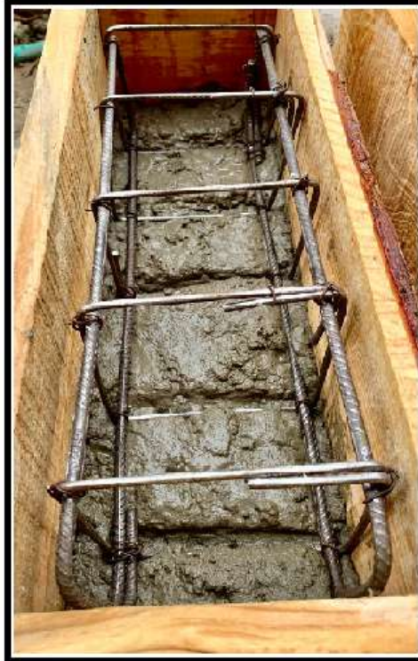
Figura 17 - Posicionamento da armadura
