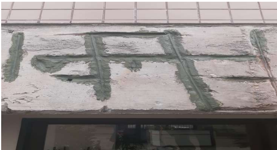
Figura 25: Armadura após aplicação de inibidor de corrosão
