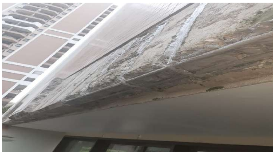
Figura 26: Armadura após aplicação do aditivo colante
