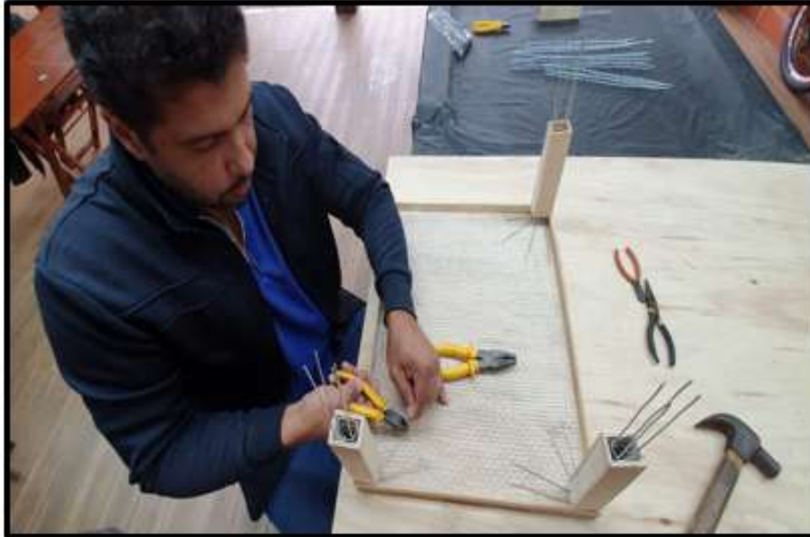
Figura 5 - Amarração dos pilares no piso
