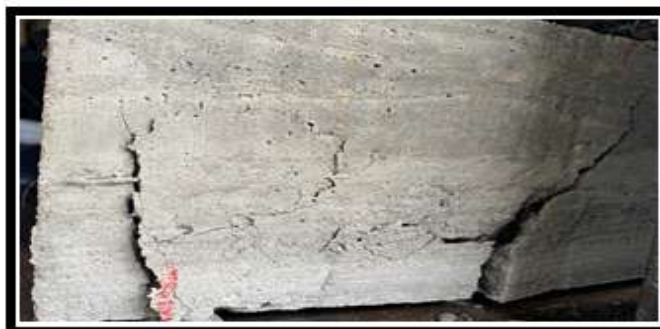
Figura 37 - Caracterização da fissuração do prisma P3
