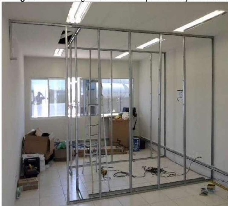
Figura 07 - Montagem do montante para formação da estrutura
