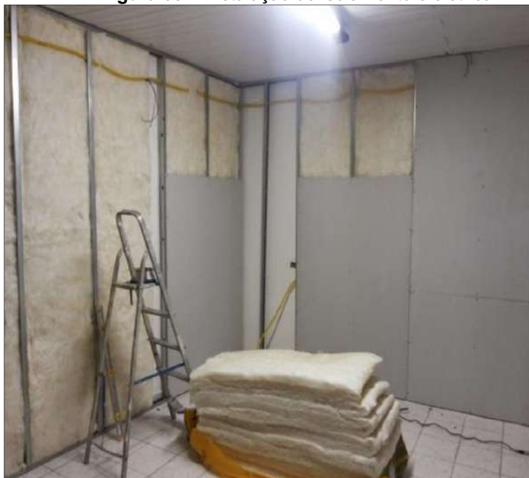
Figura 08 - Instalação do isolamento e elétrica
