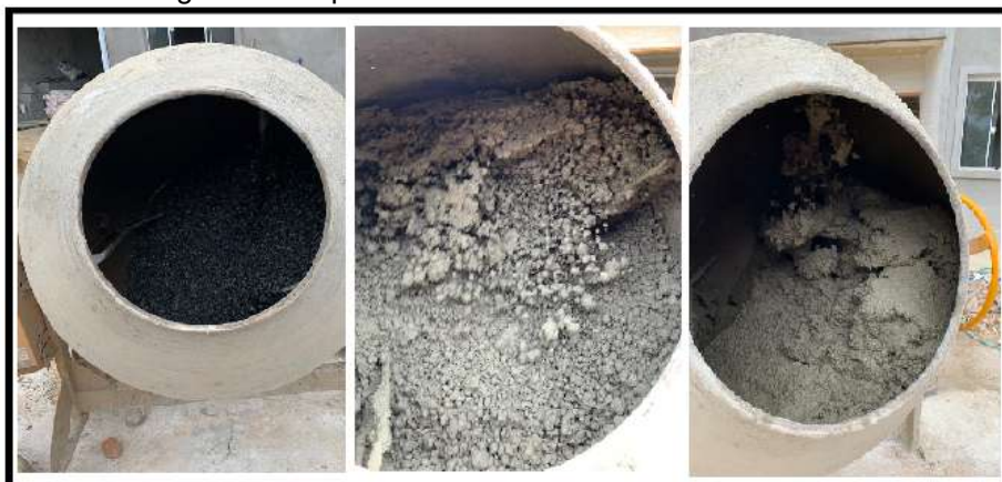
Figura 8 - Etapa de Mistura dos materiais na betoneira
