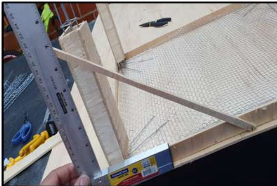
Figura 6 - Escoras de alinhamento dos pilares
