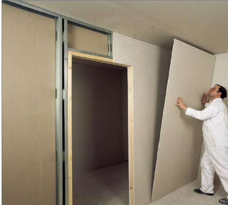
Figura 09 - Fechamento do ambiente com as placas acartonado
