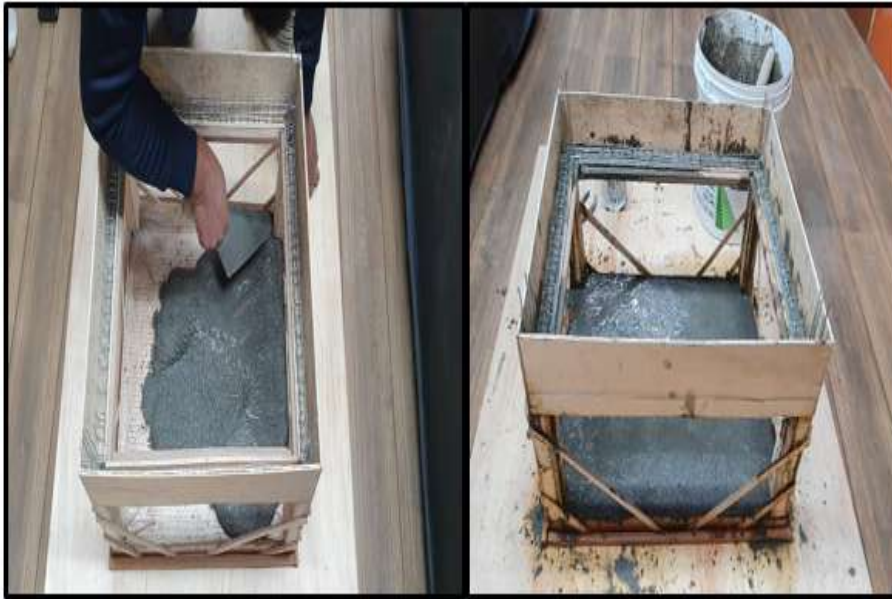
Figura 11 - Concretagem do piso, pilares e vigas
