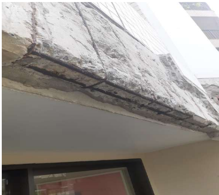
Figura 24: Viga com camada de cobrimento demolida
