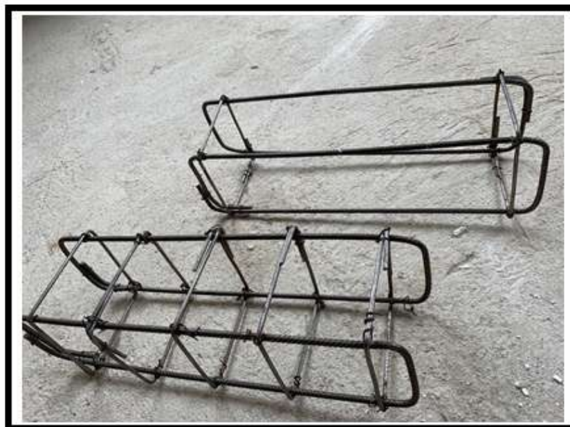
Figura 7 - Armadura transversal e longitudinal
