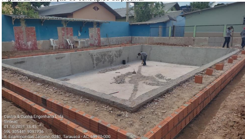
Figura 12: Demolição do contrapiso da piscina.
