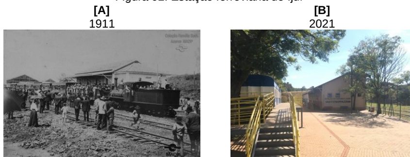
Figura 02: Estação ferroviária de Ijuí
