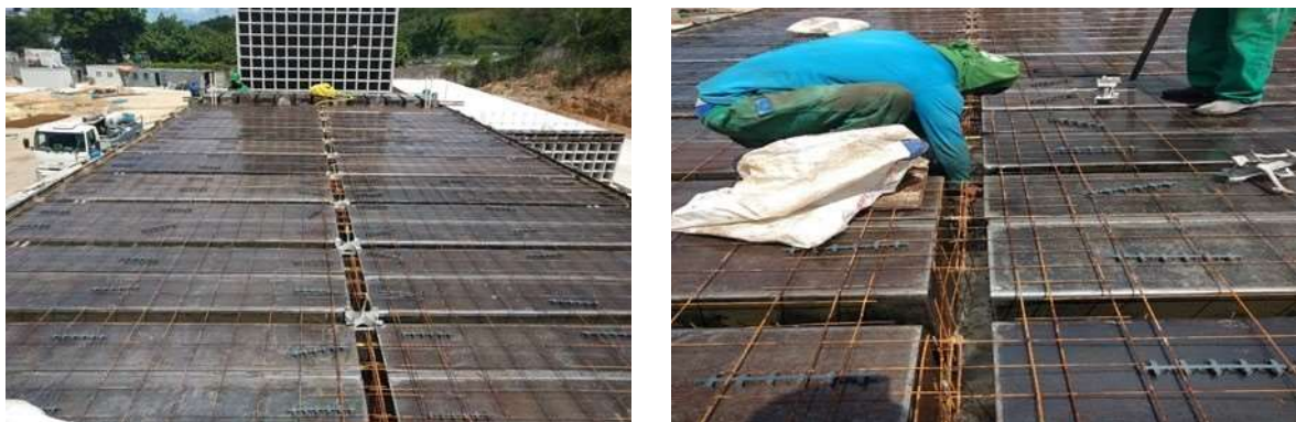
Figura 28 – (a) Tela Q61 usada para lajes e (b) Tela Q61 usada para fundo de gavetas
