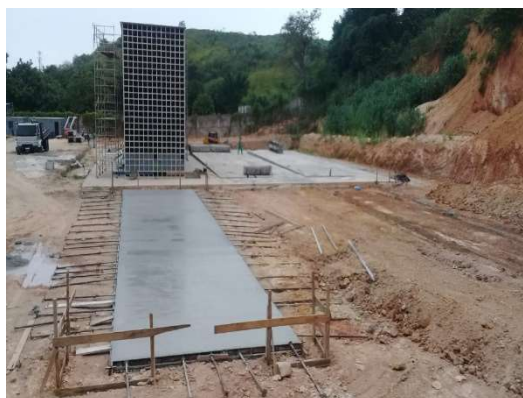
Figura 21 – Radier concretado
