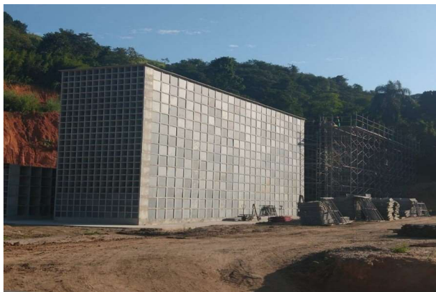
Figura 24 - Fôrmas de columbários prontas na lateral
