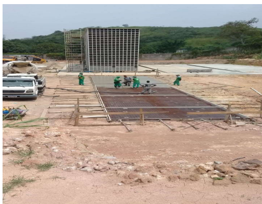
Figura 20 – Concretagem do radier
