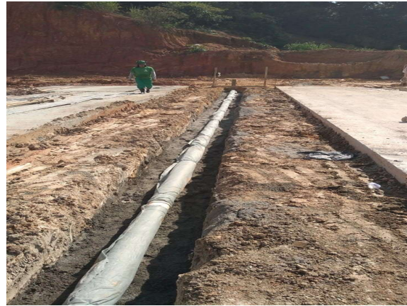
Figura 15 - Envolvimento do tubo com manta freática
