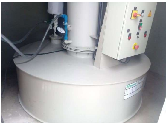
Figura 35 – (a) Dispositivo inativador de gases, (b) Tubo de CPVC no interior das gavetas, (c) Tubos de CPVC que transportam os gases e (d) Tubulação de CPVC instalado no inativador
