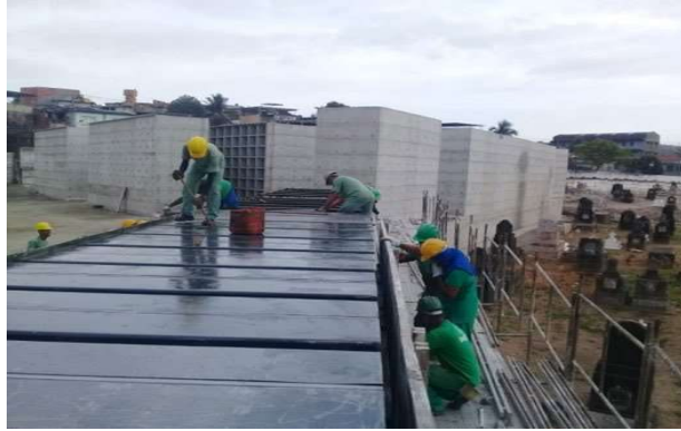
Figura 27 – Aplicação do óleo desmoldante
