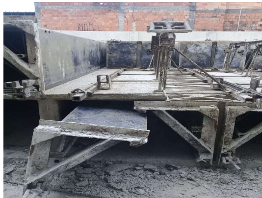
Figura 23 - Estrutura principal das gavetas verticalizadas com travamento
