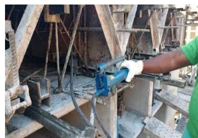
Figura 26 – (a) Esticador hidráulico, (b) Macaco hidráulico, e (c) Macaco hidráulico sendo usado para desprender a fôrma
