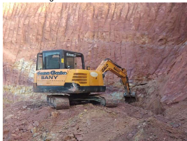
Figura 6 – Corte no terreno
