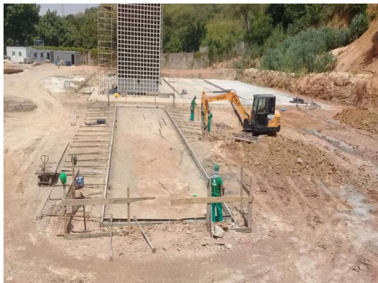
Figura 18 – Montagem do radier
