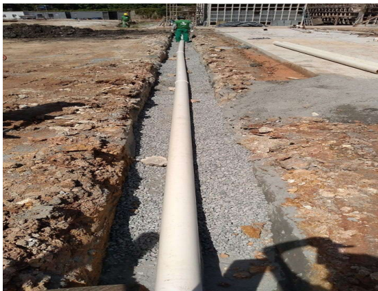
Figura 16 - Dreno vertical em colchão de brita 1
