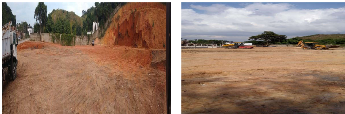
Figura 7 – (a) Preparação do terreno para compactação e (b) Compactação do terreno
