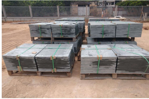
Figura 31 – Tampas em ardósia usadas para fechamento das gavetas
