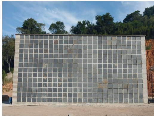
Figura 32 – Fechamento das gavetas em tampas de ardósia
