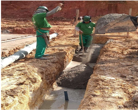
Figura 14 - Lançamento de pó de pedra no lençol Bidim
