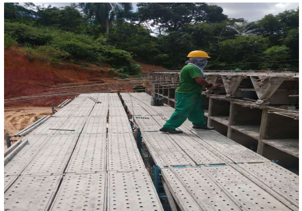
Figura 25 – (a) Treliça, (b) Tirantes sendo inseridos nas fôrmas, (c) Alinhador, (d) Porca de Ancoragem, (e) Trava de alinhamento, (f) Trava de fundo e (g) Grade de apoio
