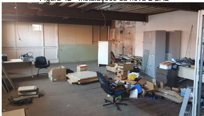
Figura 42 - Instalações da nova DGAL
