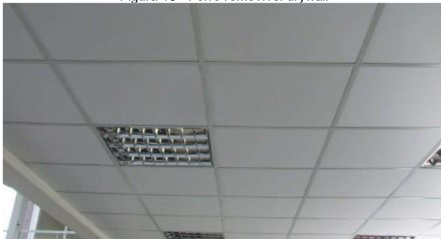
Figura 15 - Forro removível drywall
