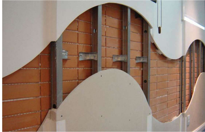
Figura 16 - Revestimento feito com drywall
