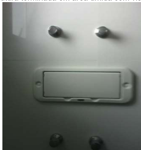
Figura 39 - Estrutura terminada em área úmida com visita para registros
