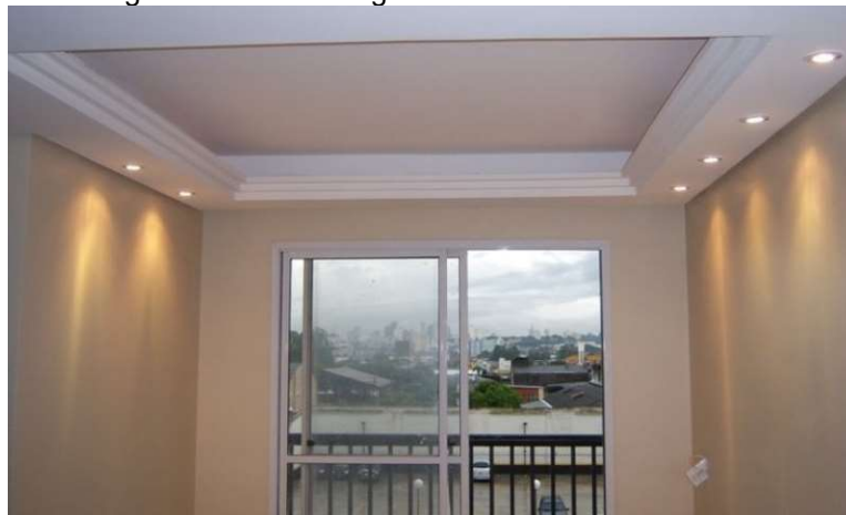
Figura 11 - Forro de gesso acartonado estruturado
