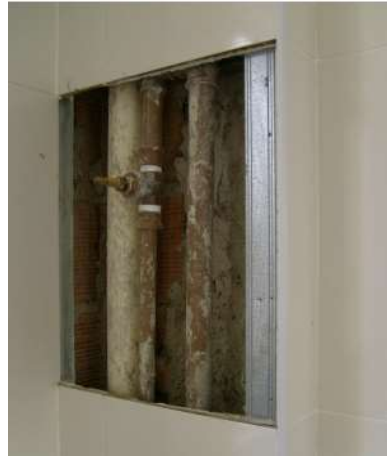
Figura 38 - Estrutura em área úmida com visita para registros
