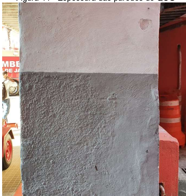
Figura 44 - Espessura das paredes do QCG
