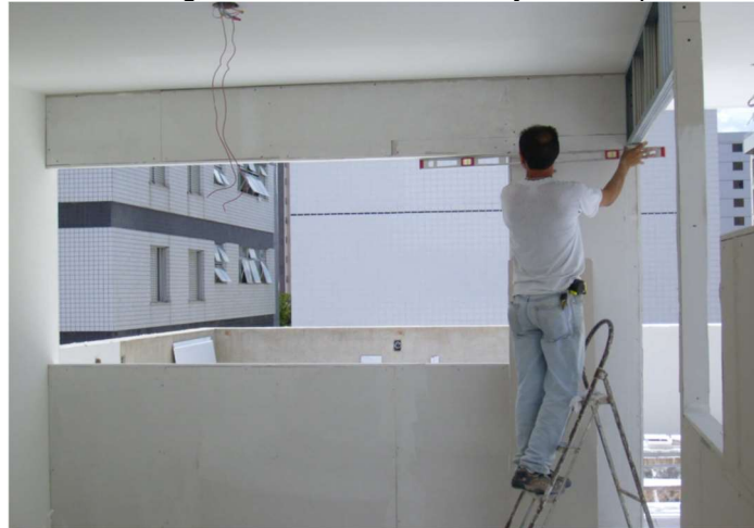
Figura 31 - Nivelamento de janelas e portas
