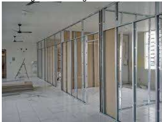
Figura 4 - Montagem da estrutura
