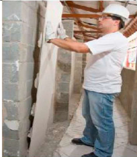
Figura 17 - Revestimento feito com colagem
