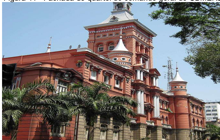
Figura 41 - Fachada do quartel do comando geral do CBMERJ
