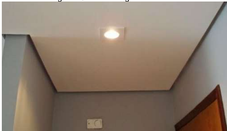
Figura 13 - Forro de gesso aramado
