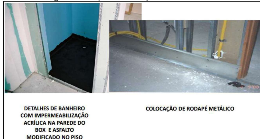
Figura 35 - Impermeabilização de áreas úmidas
