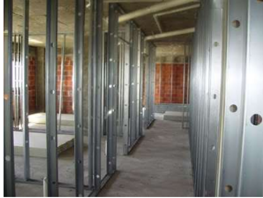
Figura 6 - Estrutura metálica das paredes de drywall
