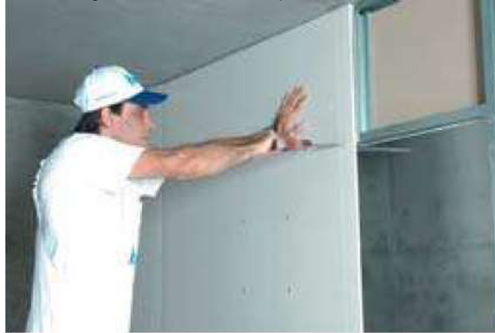
Figura 30 - Corte da chapa no vão de porta
