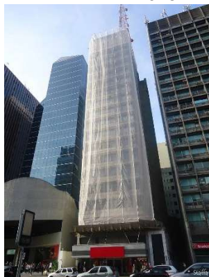
Figura 18: Edifício Paulista 2028 durante a obra
