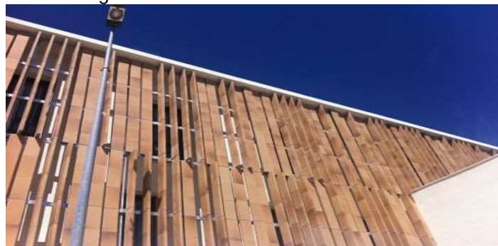
Figura 4: Fachada ventilada de cerâmica
