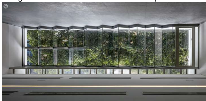
Figura 22 – Fachada do RB12 com vista para árvores
