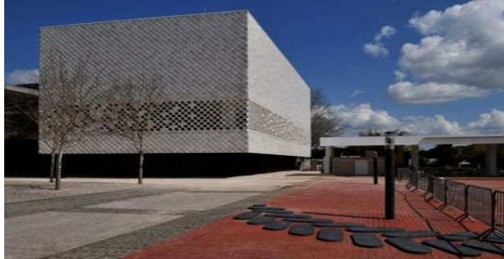
Figura 2: Fachada ventilada de concreto
