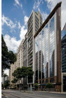
Figura 27 – Painéis fotovoltaicos instalados na lateral do RB12
