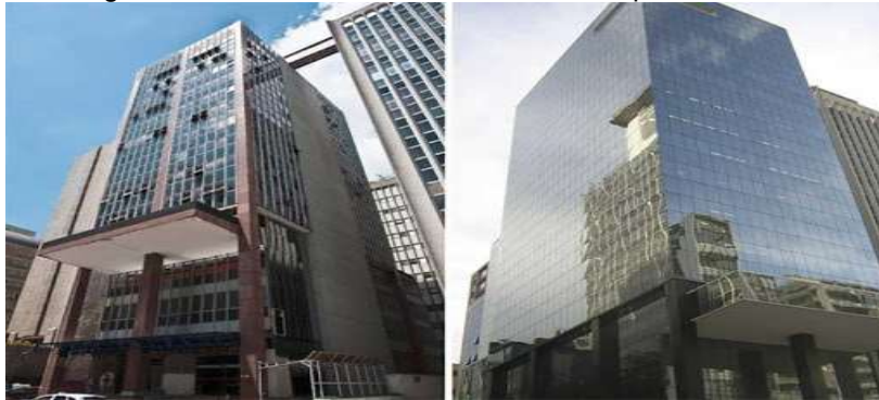
Figura 16: Edifício Bela Paulista antes e depois do retrofit
