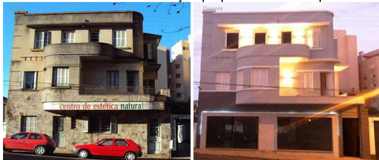
Figura 8: Fachada de uma edificação pequena antes e depois do retrofit.
