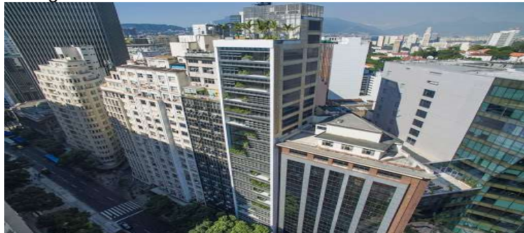
Figura 28 – Painéis fotovoltaicos do RB12 vistos de cima
