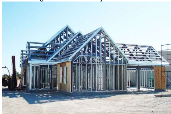
Figura 1 – Construção em LSF
