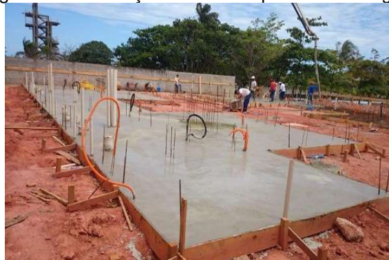
Figura 10 – Fundação em radier após a concretagem
