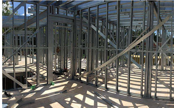
Figura 12 - Contraventamentos e bloqueadores
