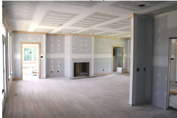
Figura 17 - Placa Standard (ST) no revestimento interno
