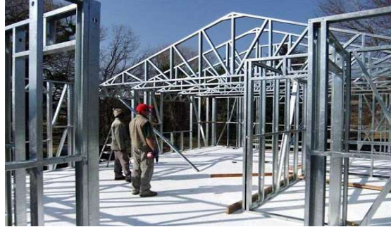
Figura 11 – Montagem utilizando o método Stick
