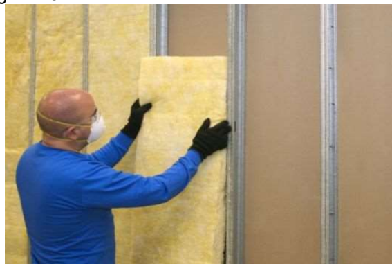
Figura 18 - Isolamento termo acústico com lã de vidro
