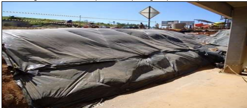
Figura 20 – Talude provisório protegido por lona plástica
