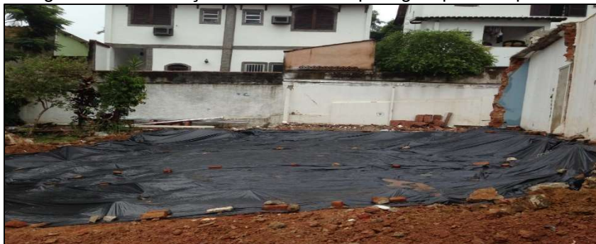
Figura 21 – Escavação em andamento protegido por lona plástica
