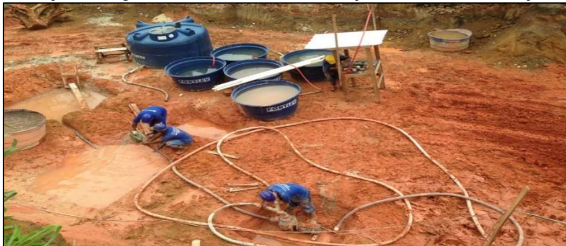
Figura 29 – Utilização de água de rebaixamento de lençol freático na execução de estaca raiz
