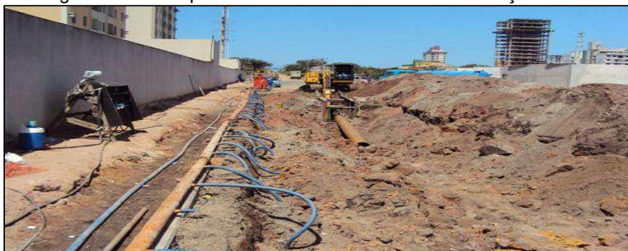
Figura 28 – Exemplo de sistema de rebaixamento de lençol freático
