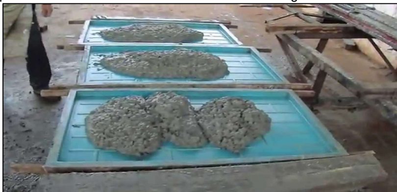
Figura 32 – Aproveitamento de sobra de concreto com concretagem de elementos arquitetônicos
