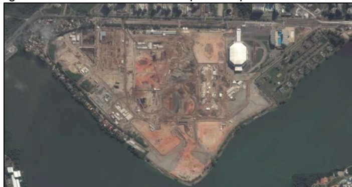
Figura 3 – Canteiro de obra Parque Olímpico - Rio de Janeiro
