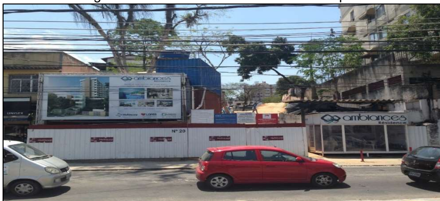
Figura 15 – Uso de container na área de apoio
