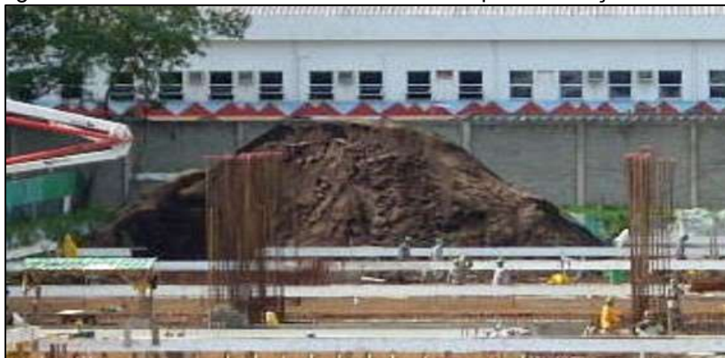
Figura 30 – Material escavado e armazenado para utilização em aterro
