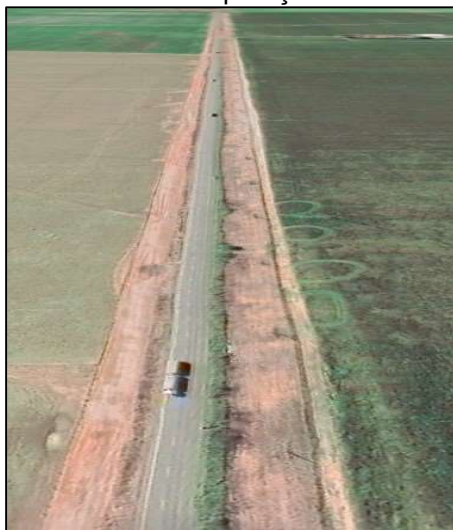
Figura 5 – Canteiro de obra duplicação BR-364 – Mato Grosso
