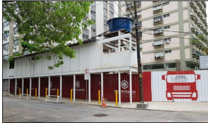
Figura 2 – Canteiro de obra Condomínio Borges 3647
