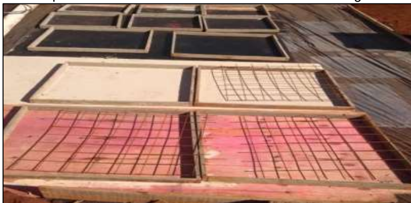
Figura 31 – Aproveitamento de sobra de concreto com concretagem de tampas
