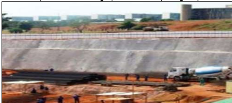
Figura 22 – Talude provisório de longa permanência protegido por tela e chapisco.
