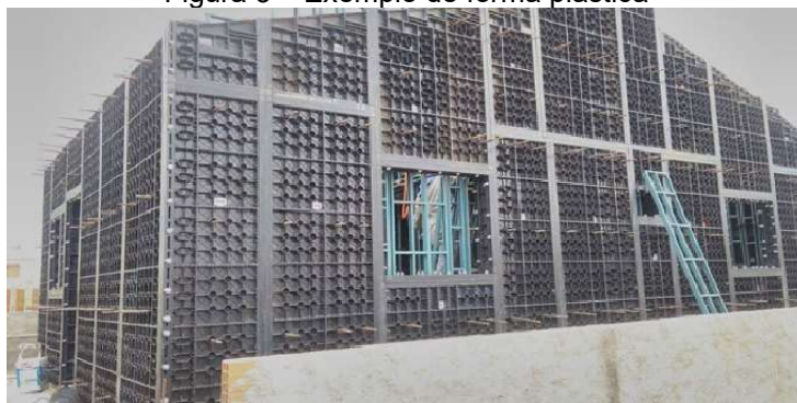
Figura 3 – Exemplo de fôrma plástica
