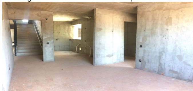
Figura 7 – Interior da estrutura após desforma
