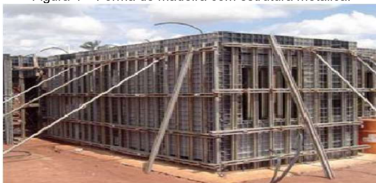
Figura 4 – Fôrma de madeira com estrutura metálica.
