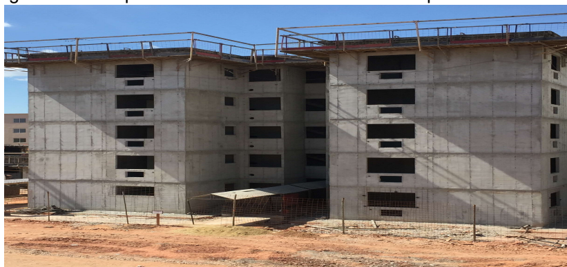
Figura 1 - Exemplo de edifício construído no método parede de concreto
