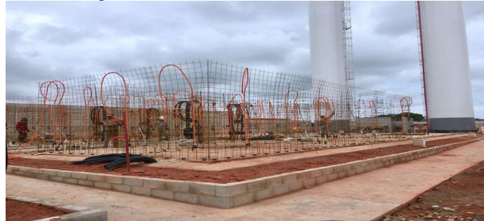
Figura 5 – Posicionamento da armadura
