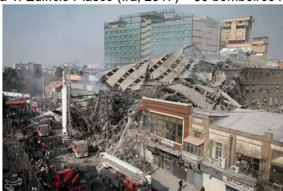
Figura 1: Edifício Plasco (Irã, 2017) – 30 bombeiros mortos
