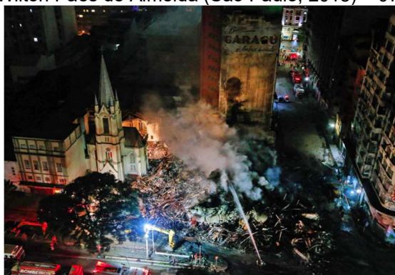
Figura 2: Edifício Wilton Paes de Almeida (São Paulo, 2018) – 07 ocupantes mortos
