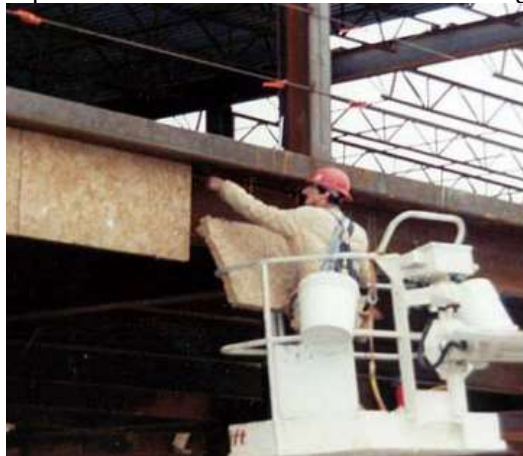
Figura 29: Operário instalando o Cafco-Board® em viga metálica
