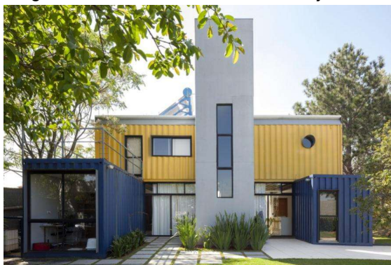
Figura 10 – Casa Container da Granja Viana
