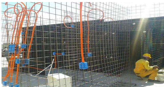
Figura 4- Instalações elétricas
