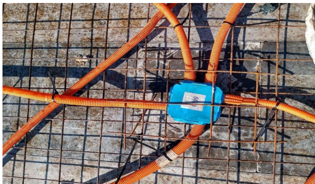
Figura 14- Caixa de passagem no teto
