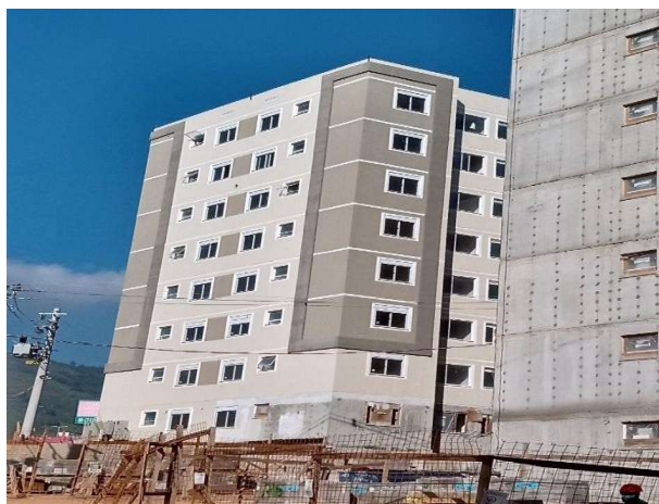
Figura 21- Obra em acabamento
