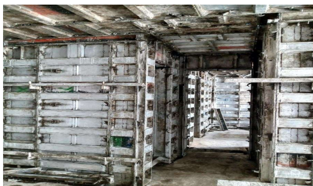
Figura 16- Fôrmas metálicas montadas
