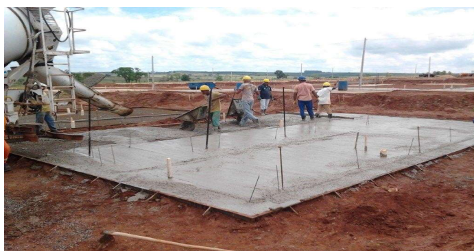
Figura 2- Fundação radier
