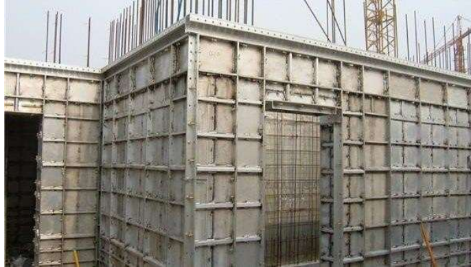
Figura 6- Formas metálicas em alumínio
