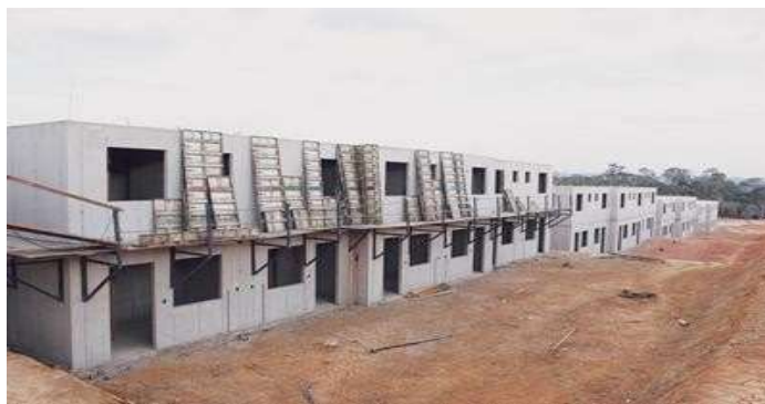
Figura1. Paredes de concreto
