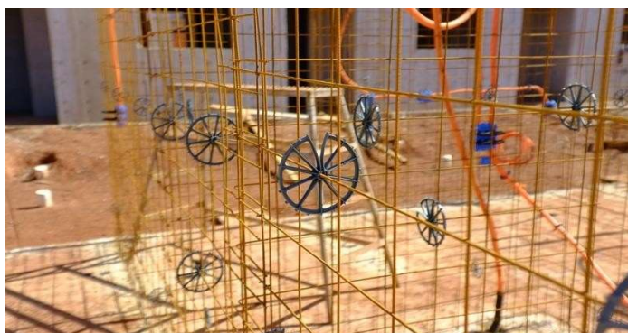
Figura 3- Telas de aço eletrossoldadas para Paredes
