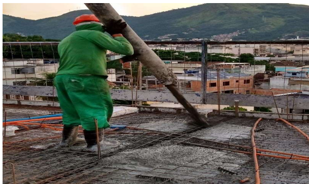
Figura 19- Concretagem
