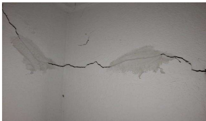
Figura 6 - Trinca
