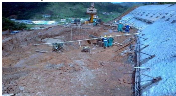
Figura 42 - Construção de cortina atirantada em Nova Friburgo
