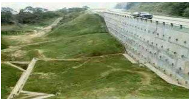
Figura 41 - Construção de parede diafragma
