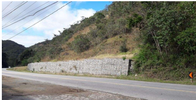
Figura 38 - Construção de Gabiões em Nova Friburgo
