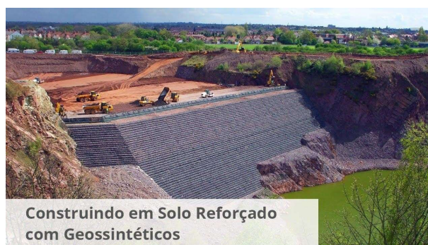
Figura 44 - Construção de Geossintéticos
