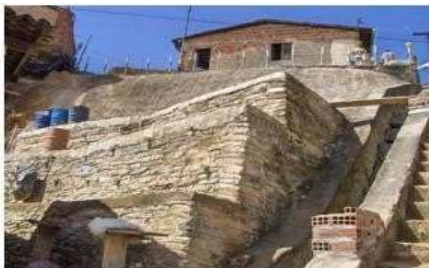
Figura 45 - Muro de solo-cimento ensacado no município do Cabo de Santo Agostinho- PE.
