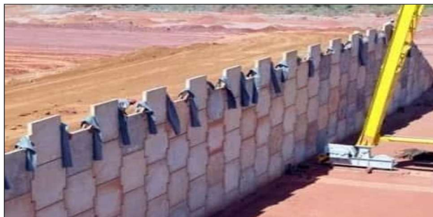
Figura 43 - Construção de solo armado
