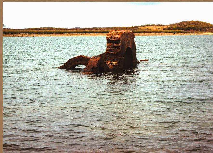
Figura 6: Ruínas de Igreja da Segunda Canudos.
