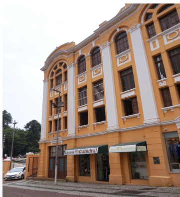
Figura 8: Fachada do prédio do antigo Cine Roxy em 2024
