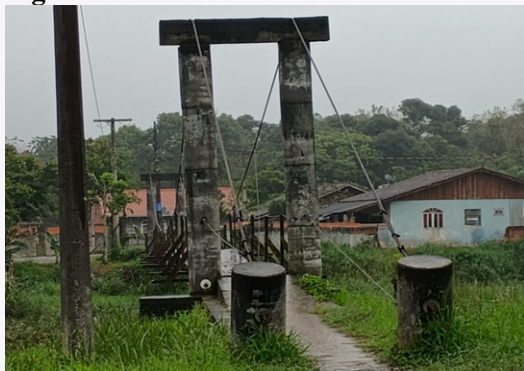
Figura 8 – Ponte Pênsil atualmente
