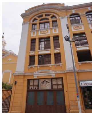
Figura 9: Fachada do antigo Cine Roxy em 2024
