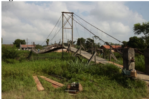
Figura 7 – Ponte Pênsil antes da reforma de 2015
