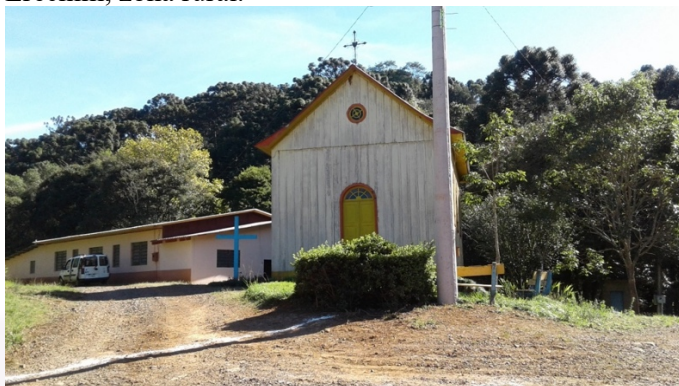
Fig. 4. Capela Santa Teresa e salão comunitário. Rio Negro, Erechim, zona rural.
