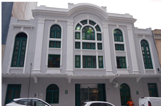
Figura 13: Fachada do prédio como escola em 2024
