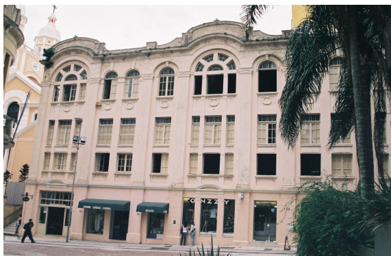
Figura 6: Fachada do prédio do antigo Cine Roxy em 2008
