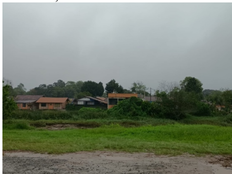
Figura 3 – Entorno imediato da Ponte Pênsil sobre o Rio Cubatão, conhecida como Ponte de Arame
