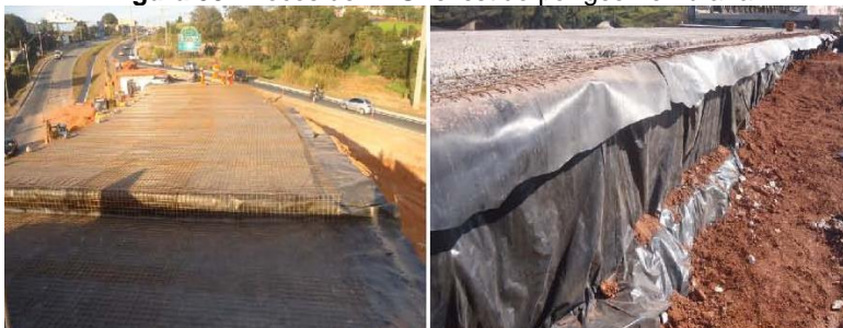
Figura 03: Blocos de EPS revestido por geomembrana
