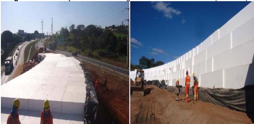
Figura 05: Construção da Rodovia Engenheiro Constâncio Contra (SP – 360)
