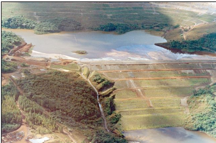
Figura 4: Barragem sul superior, em barão dos cocais, utiliza o método a montante
