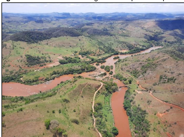
Figura 6: Rios Carmo e Piranga 5 anos após o rompimento
