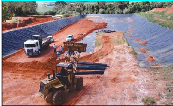
Figura 6: Impermeabilização superior e inferior.
