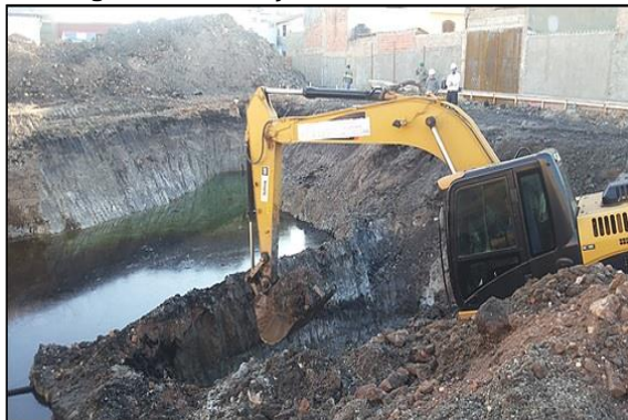
Figura 2: Escavação de área contaminada
