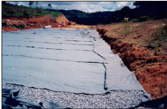
Figura 05: Colchão drenante de brita com recobrimento de geotêxtil.
