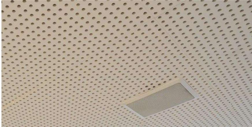
Fonte: Forro acústico em chapa de gesso cartonado perfurado - Speed Dry
