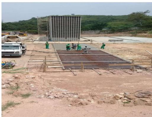
Figura 21 – Radier concretado
