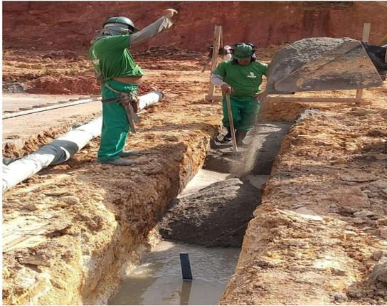
Figura 15 - Envolvimento do tubo com manta freática
