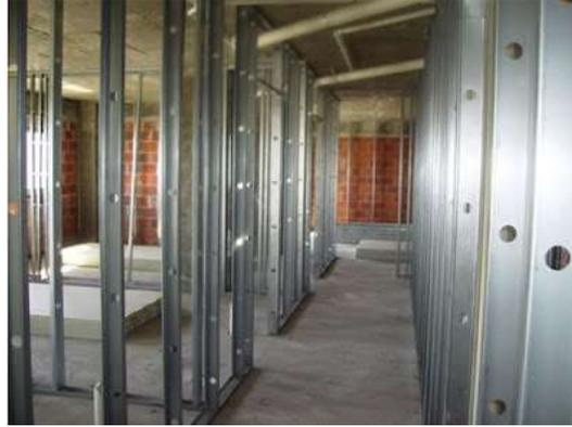
Fonte: Sil gesso Projetos & Decorações: 1 - estrutura metálica para parede drywall
