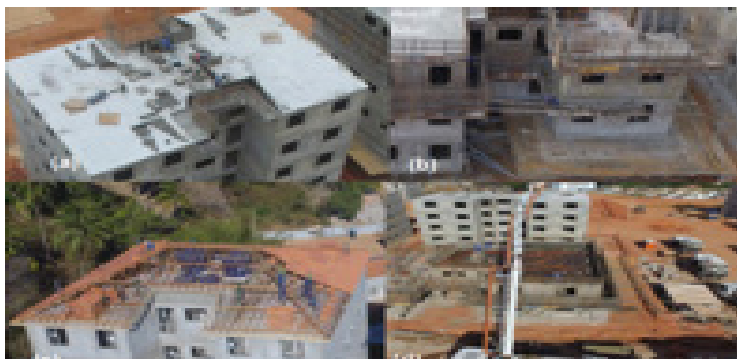
Figura 4. Vista ampla do canteiro de obras
