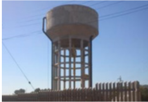
Figura 1. Reservatórios elevados de concreto armado
