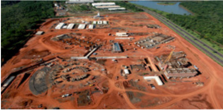
Figura 1. Canteiro de obras
