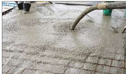
Figura 5: Concreto auto adensável
