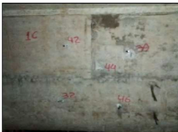
Figura 16: Ponto 1C localizado na viga do teto do 1º subsolo
