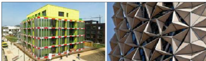
Figura 3: Tipos de Fachadas com parede de algas e sensível a luz que respira
