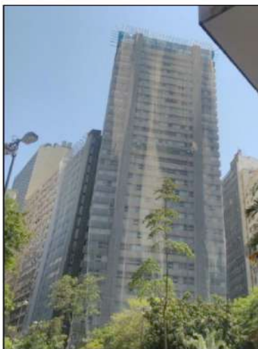
Figura 9: Edifício Lúcio Costa em processo de restauro
