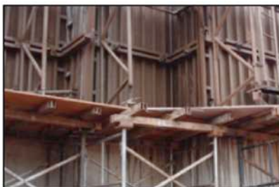
Figura 8: Fôrma de aço
