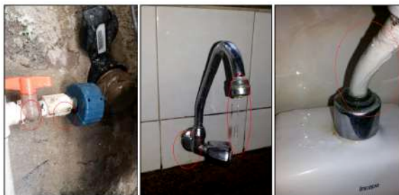
Figura 10: Dependências da Igreja em Anchieta (2017)
