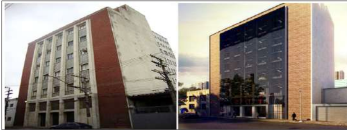
Figura 1: Melhoria das edificações existentes.
