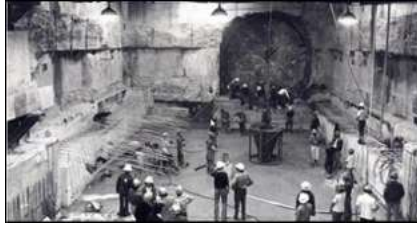
Figural: Primeiras obras da construção do metrô de São Paulo, Estação de São Bento.
