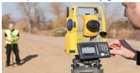
Figura 3: Exemplo de execução de levantamento topográfico com estação total.
