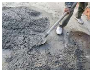
Figura 1: Concreto virado na obra; Figura 2: Concreto Bombeado
