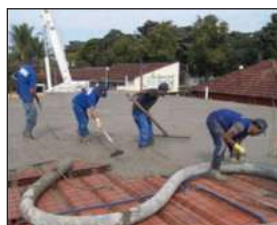
Figura 1: Concreto virado na obra; Figura 2: Concreto Bombeado
