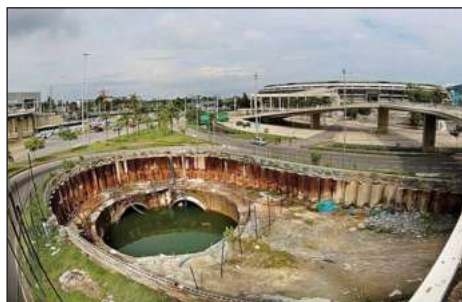
Figura 2: Obra do Programa de Combate às Enchentes da Grande Tijuca.
