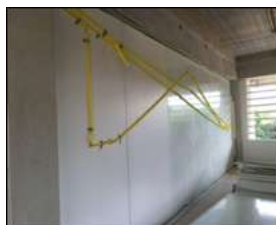
Figura 16: Passagem dos conduítes. Figura 17: Instalações elétricas finalizada.
