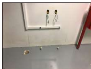
Figura 15: Carenagens das tubulações.
