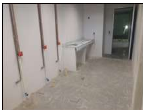
Figura 14: Instalação hidráulica e da bancada de mármore.
