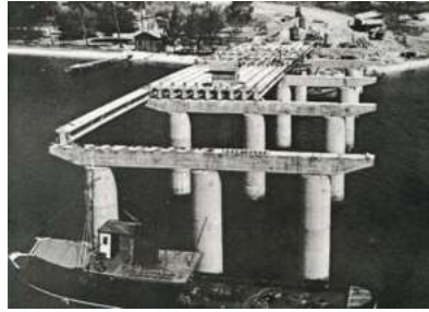
Figura 1: Vigas longitudinais pré-moldadas protendidas
