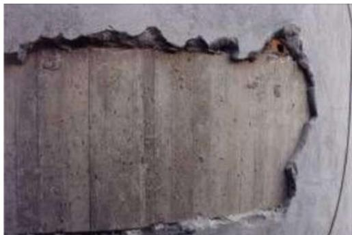
O deslocamento ocorre quando existe uma ruptura entre o substrato e o revestimento de argamassa, que dentro de todo o emboço e o reboco. Quando estes são submetidos a ensaios de percussão, as placas apresentam som cavo e, dependendo do mecanismo atuante, podem ter aspecto endurecido ou quebradiço (BAUER, 2008).
