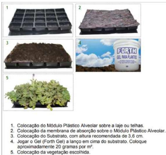
1. Colocação do Módulo Plástico Alveolar sobre a laje ou telhas.
