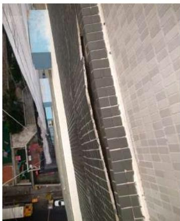
Figura 10: Deterioração das pastilhas
