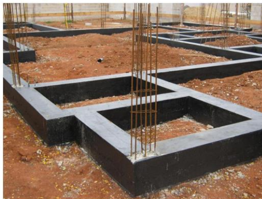
Figura 1: Viga baldrame impermeabilizada
