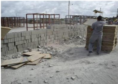
(e) Armazenamento no pátio de estocagem
