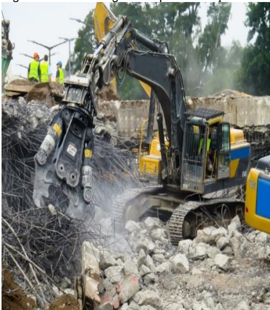
Figura 6 – Entulhos gerados por demolição.
