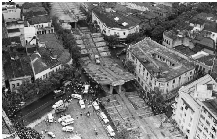
Figura 12 – Desabamento, no início dos anos 1970.
