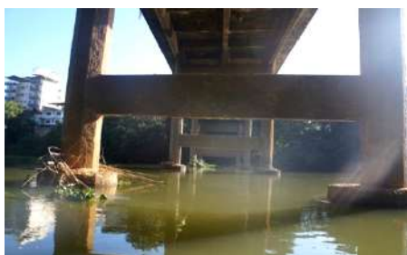
Figura 10 - Pilares: deslocamento de cobrimento do deslocamento
