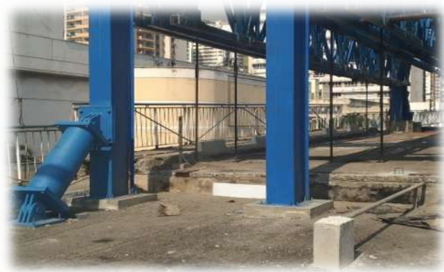
Figura 12 – Macaco hidráulico no Viaduto Padre Fonte: Defesa Civil de Nova Iguaçu
