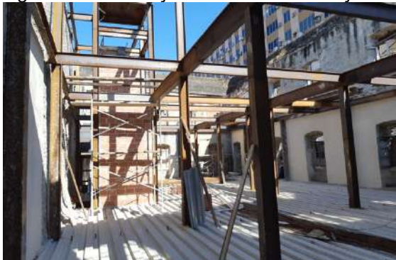
Figura 17: Construção da estrutura em aço
