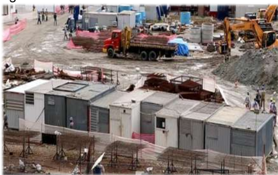
Figura 1: Canteiro de obras
