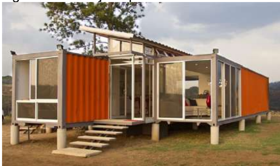
Figura 4: Fundações para Container
