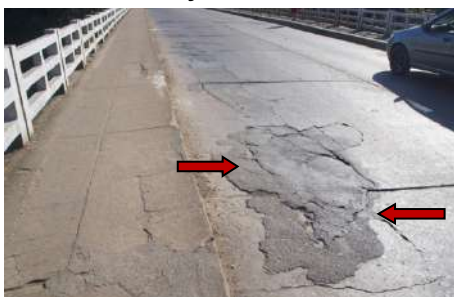
Figura 21 – Deformações asfálticas
