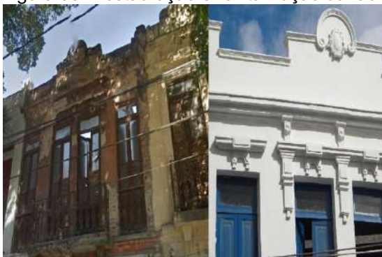
Figura 03: Restauração e revitalização da fachada
