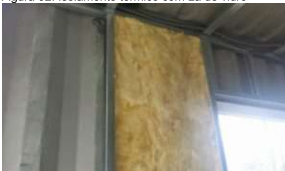
Figura 52: Isolamento térmico com Lã de vidro
