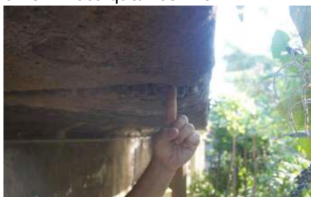
Figura 23 – Recalque/Desnível
