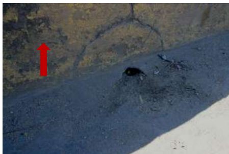
Figura 6 – Drenos danificados
