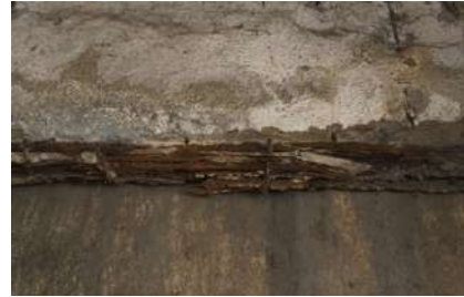
Figura 4 – Carbonatação
