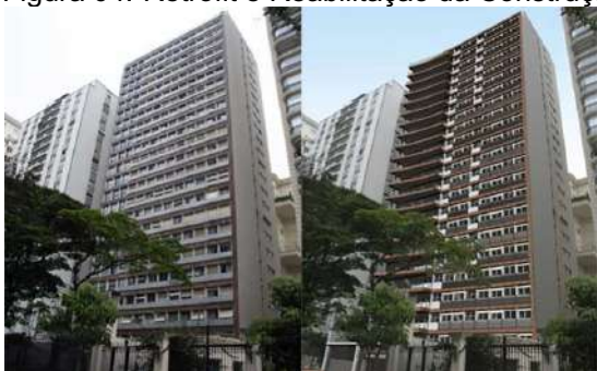
Figura 04: Retrofit e Reabilitação da Construção
