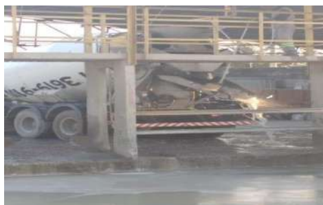
Figura 2: Lavagem dos caminhões betoneira
