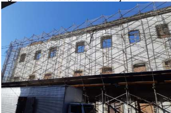
Figura 12: Fachada em restauração
