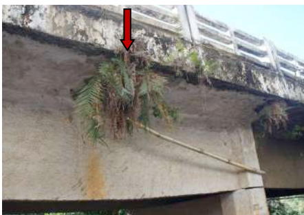
Figura 5 - Infiltração
