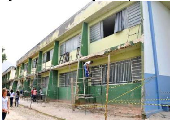
Figura 02: Reforma Colégio Municipal Astério Alves de Mendonça
