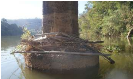
Figura 16 – Parte de pilar e bloco de fundação
