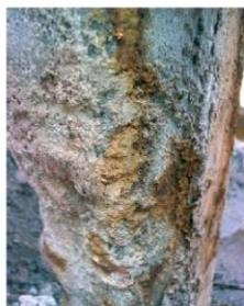
Figura 26 – Degradação apresentada em pilar de estrutura em contato com produtos químicos para fabricação de fertilizantes
