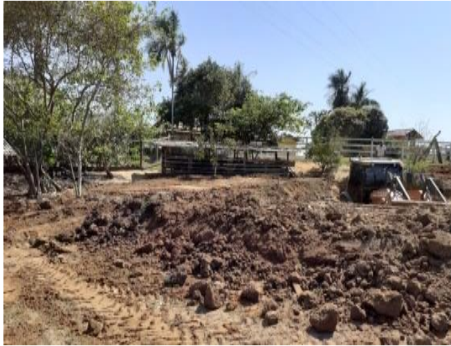
Figura 6: O poço sendo escavado
