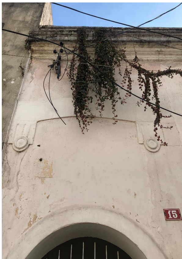
Figura 1 -Patologia (vegetação) identificada na casa n.15, Vila Economizadora – São Paulo- SP. Fonte: Autores, março de 2019.
