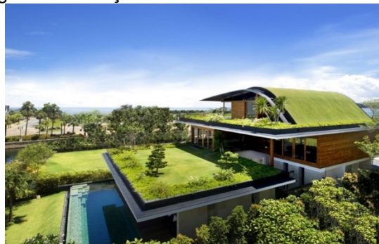
Figura 1: Utilização do telhado verde em residência
