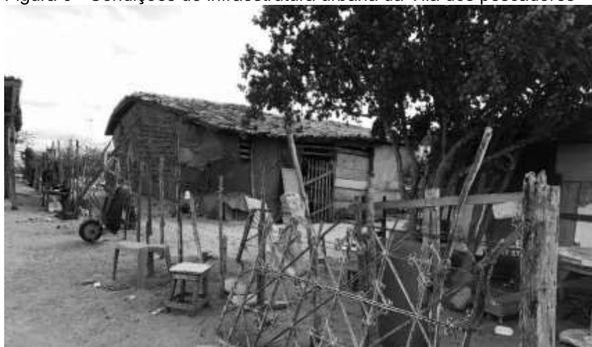
Figura 6 - Condições de infraestrutura urbana da Vila dos pescadores
