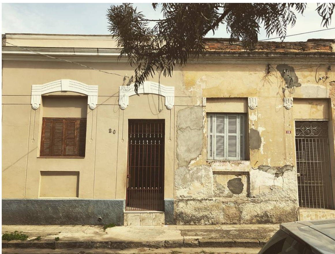
Figura 3 –Levantamento fotográfico da Vila Economizadora. Fonte: Autores, março de 2019.
