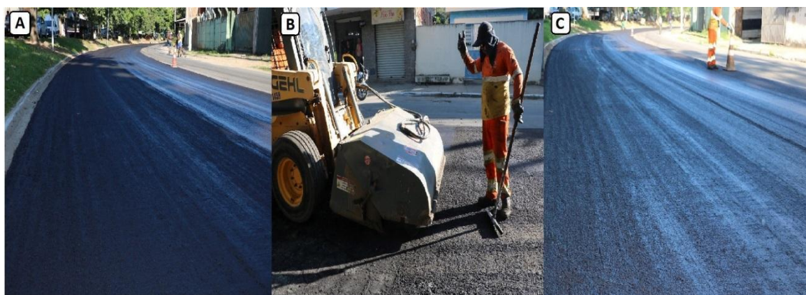
Figura 7 – Fotos da Avenida Zoelo Sola no Bairro Triângulo-Três Rios sendo asfaltada. Fonte: Rádio 3Rios, 2020.
