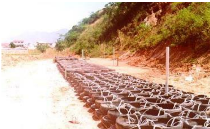
Figura 3 – Fase intermediária: amarração dos pneus entre si com cordas de polipropileno (Medeiros et al., 2000).
