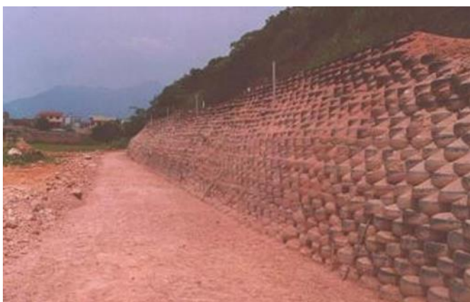
Figura 4 – Fase final da construção do muro (Medeiros et al., 2000).
