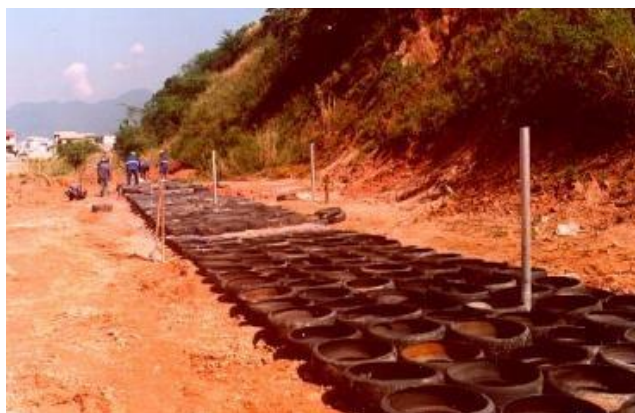
Figura 2 – Fase inicial onde foi posicionada a primeira camada de pneus (Medeiros et al., 2000).
