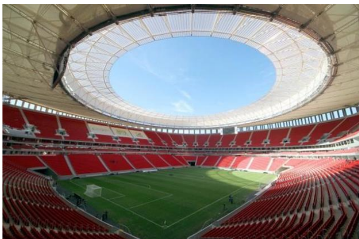
Figura 04: Imagem inferior da cobertura do estádio
