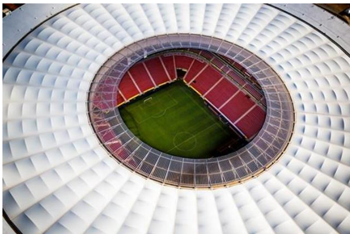
Figura 05: Imagem superior da cobertura do estádio
