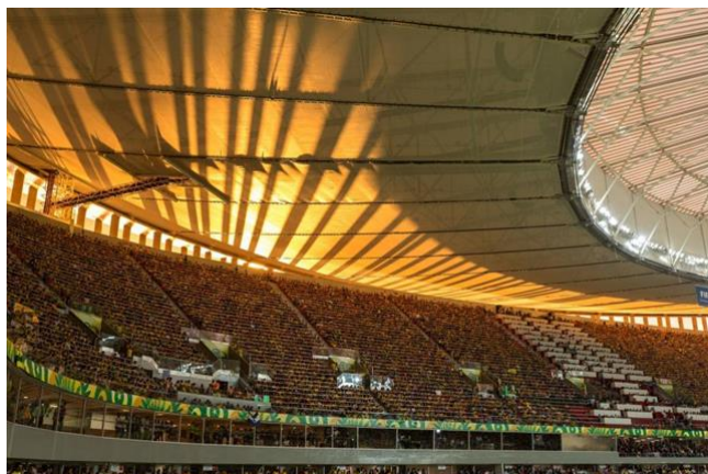
Figura 03 – Imagem interna do estádio demonstrando parte no anel compressão e sua cobertura
