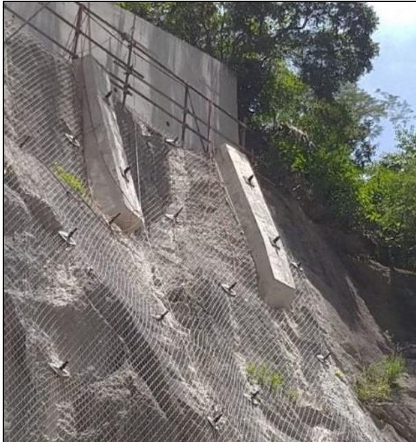
Figura 4: Contraforte executado na Crista de Talude.
