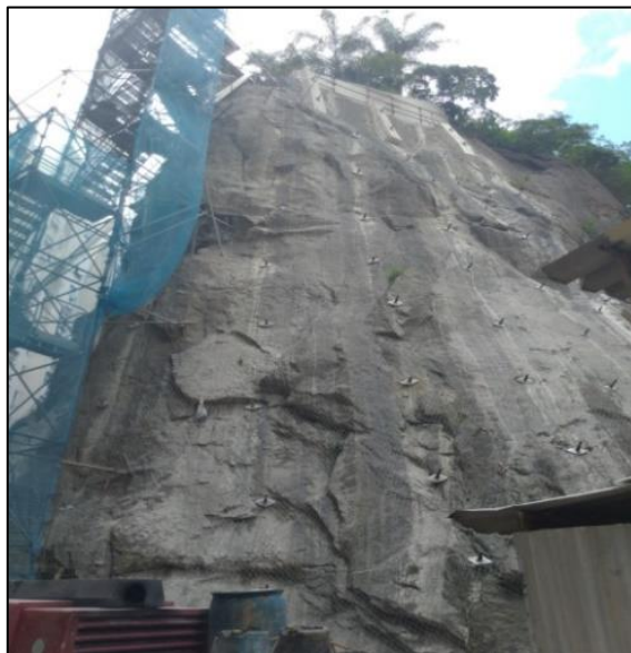
Figura 1: Talude em processo de Estabilização do Maciço Rochoso.
