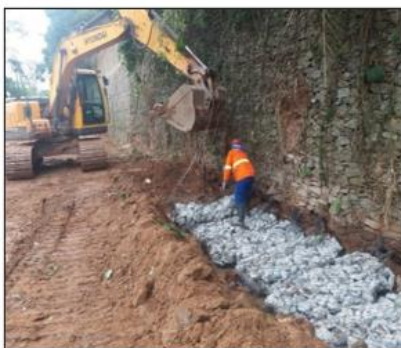
Figura 6: Montagem do Gabião tipo saco Figura 7: Detalhamento do Gabião tipo Saco
