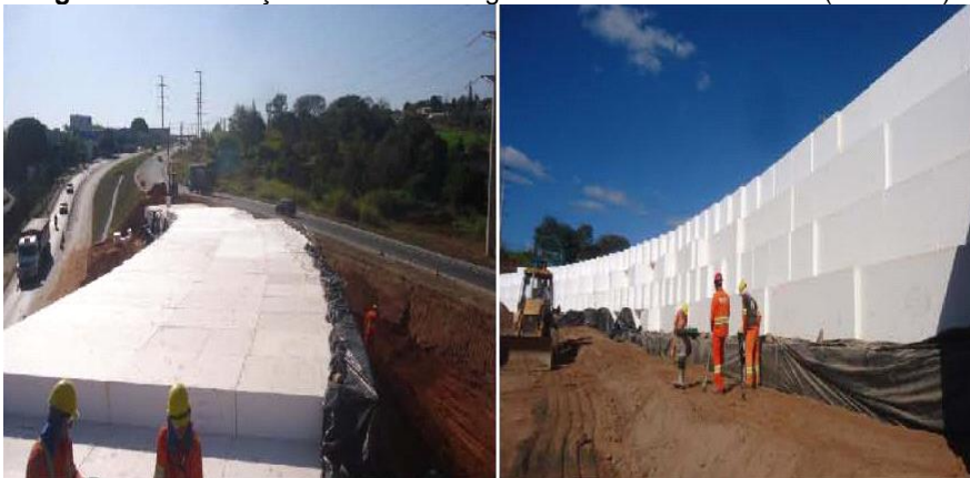
Figura 05: Construção da Rodovia Engenheiro Constâncio Contra (SP – 360)
