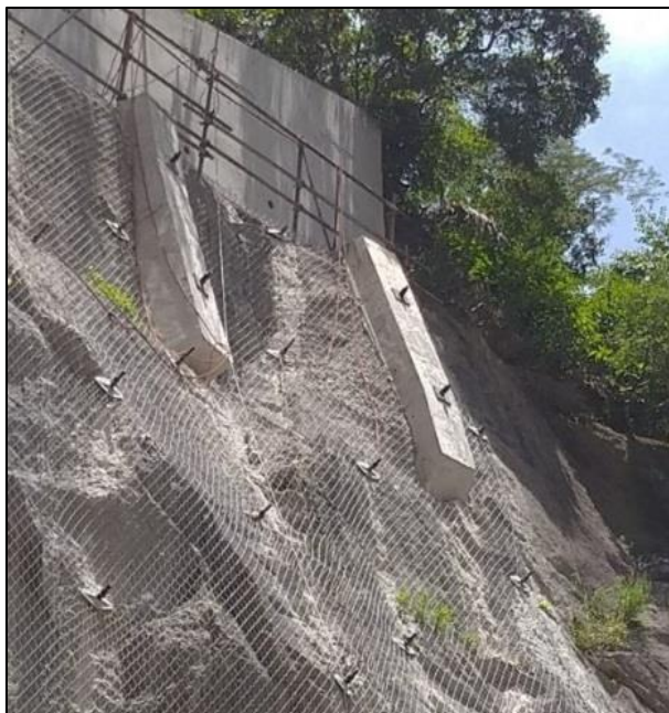
Figura 4: Contraforte executado na Crista de Talude.
