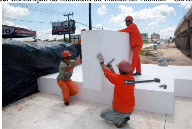
Figura 06: Construção da cabeceira do viaduto de Tubarão – Santa Catarina
