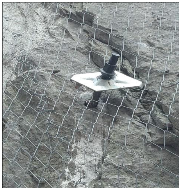
Figura 3: Tela fixada no Maciço Rochoso com Placa P33
