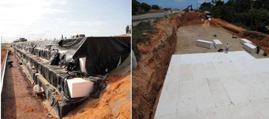
Figura 07: Duplicação da Rodovia BR 101
