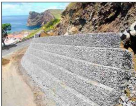
Figura 3: Muro em Gabião
