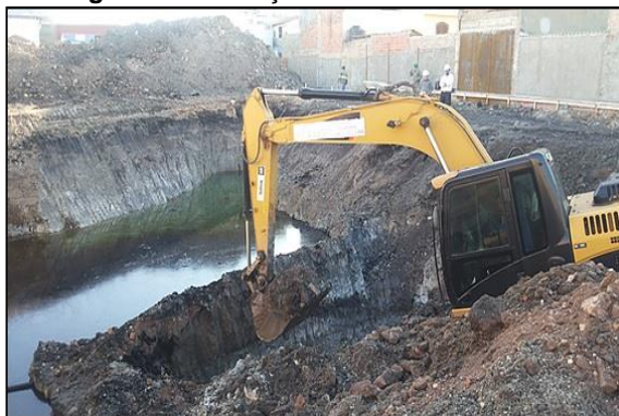
Figura 2: Escavação de área contaminada
