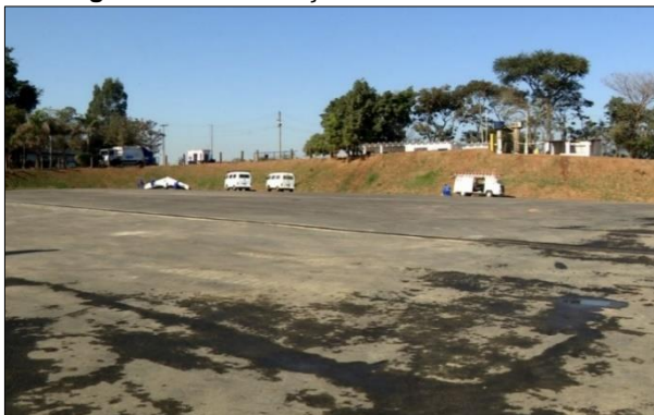
Figura 7: Pavimentação de área contaminada
