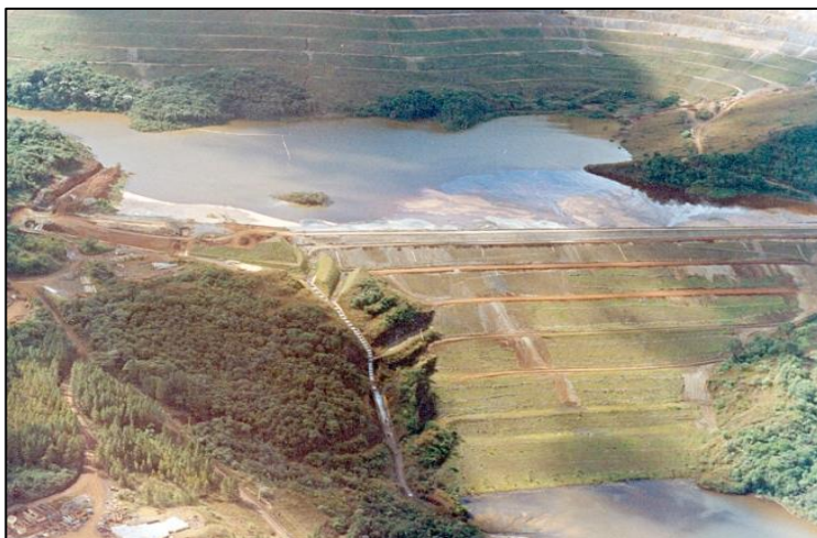
Figura 4: Barragem sul superior, em barão dos cocais, utiliza o método a montante
