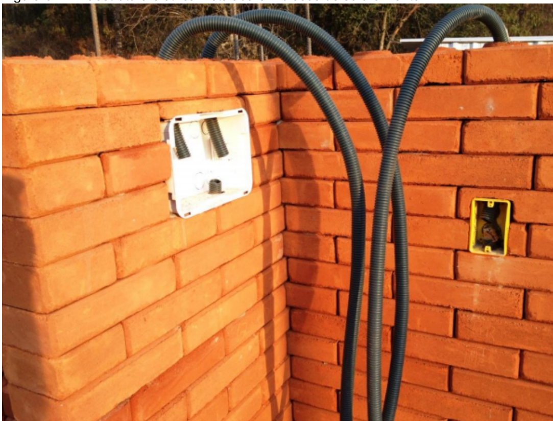
Figura 02: Infraestrutura elétrica instalada em blocos de solo-cimento
