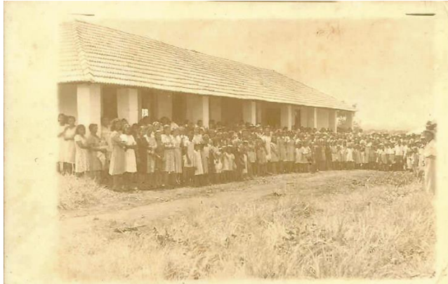
Primeira Escola de Itaguaru, construída no ano de 1946. Chamava Grupo Escolar Napoleão Pires de Barros. Foi demolida por volta de 1958. Fonte: Dilma Pires de Carvalho
