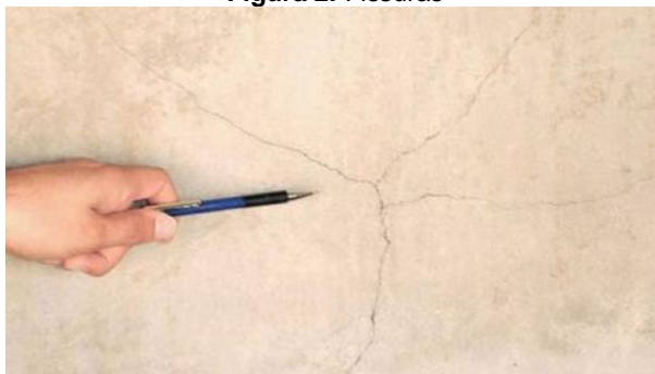
Figura 2: Fissuras
