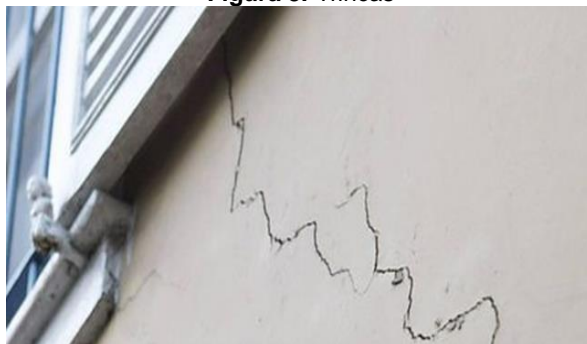
Figura 3: Trincas
