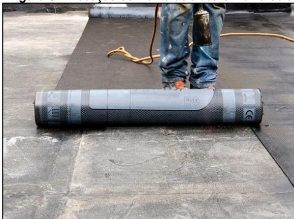
Figura 5: Execução de manta asfáltica em uma obra
