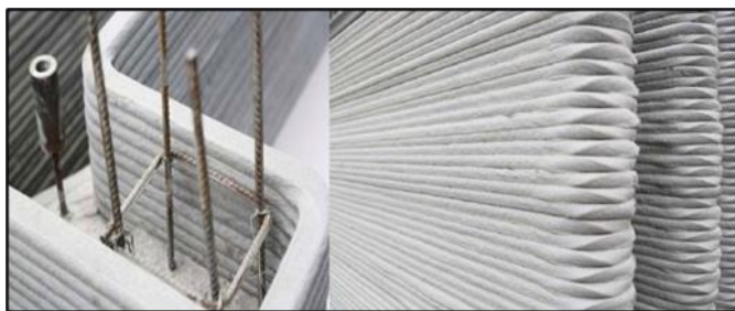
Figura 3: Parede confeccionada com impressora 3D, com destaque para as camadas
